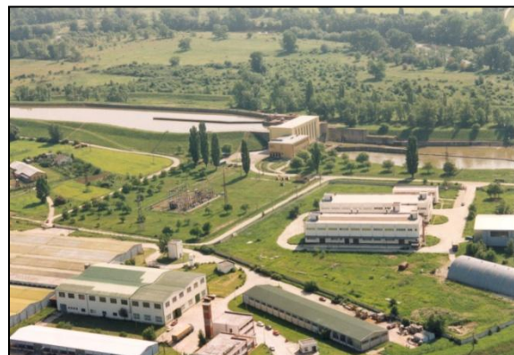
Fig. 6 HPP Horná Streda
