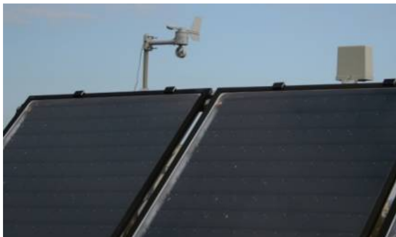
Snímače meteorologickej stanice
