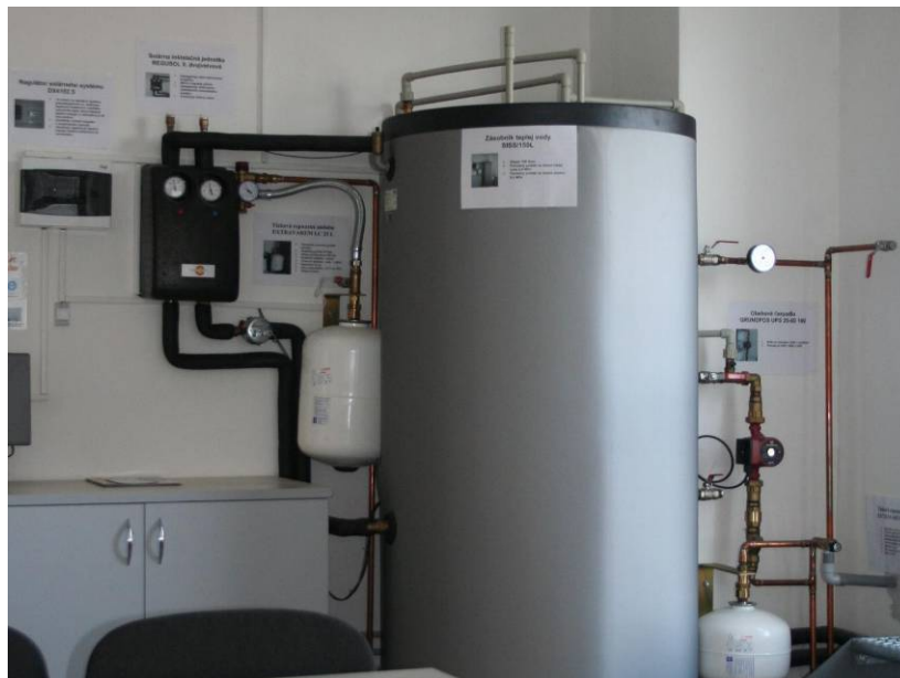
Akumulačná nádrž teplej vody (SOLAR akumulčný bojler SISS/150L) s celkovým objemom 550 litrov (l) a objemom na ohrievanú vodu 150 l
