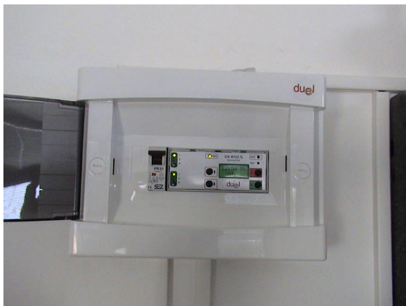
Riadiaca jednotka s digitálnym výstupom veličín do počítača, softvérom pre vyhodnocovanie nameraných údajov
