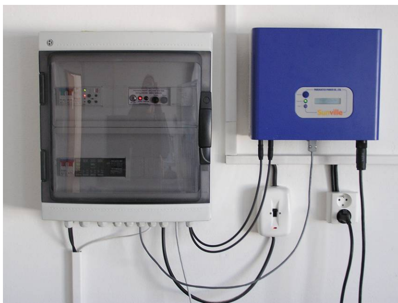
Riadiaca a kontrolná jednotka fotovoltického systému s meničom napätia
