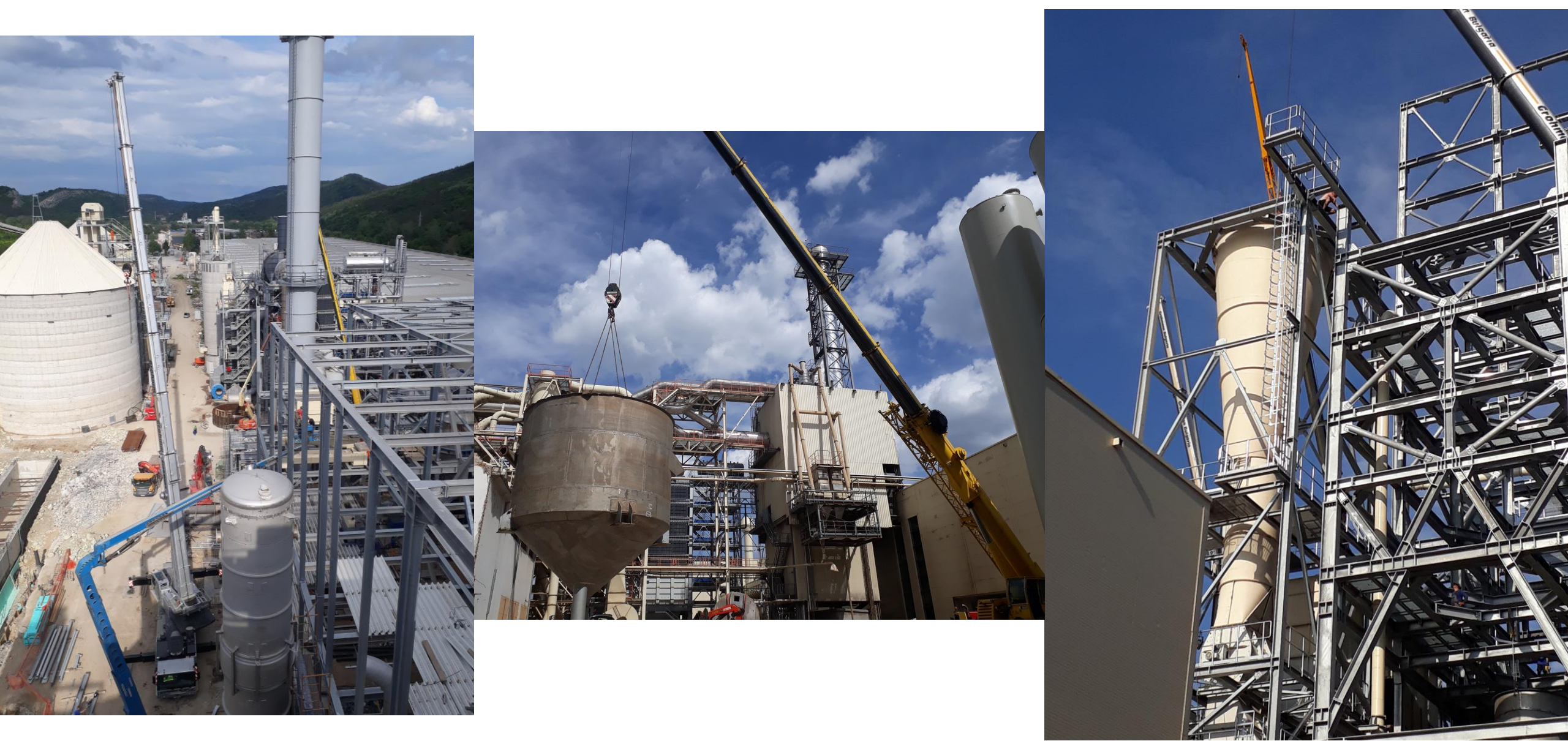
KRONOSPAN, BULHARSKO – MONTÁŽ POTRUBIA, PARA A NAPOJENIE PAROGENERÁTORU
