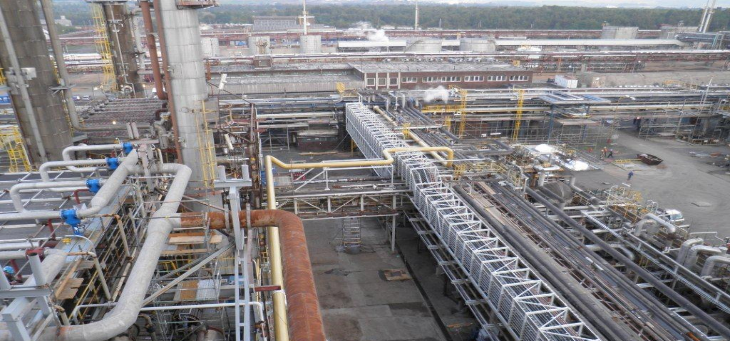
MONTÁŽ FLÉROVÉHO POTRUBIA NA VRCH KOLÓNY, LITVÍN OV, ČESKÁ REPUBLIKA
