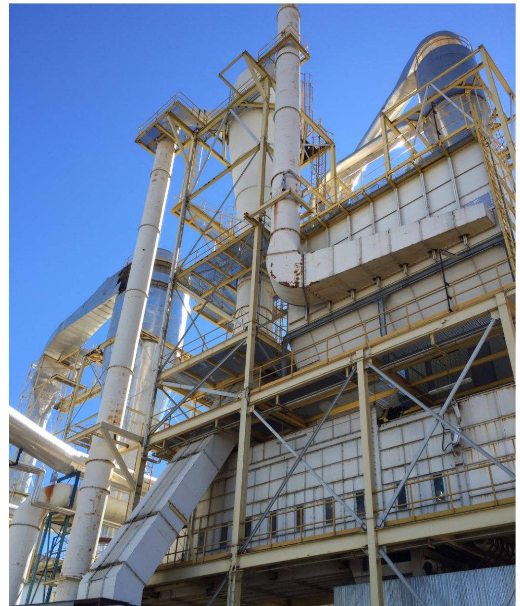
DEMONTÁŽ TECHNOLOGIE LINKY MDF, ŠPANIELSKO – ČASŤ BEREICH 1 RAFINER
