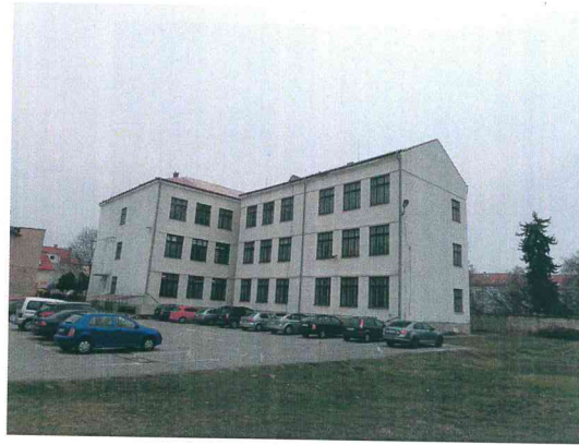
pohľad z dvora
