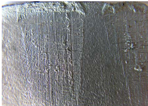
Obr. 3. Plocha pásu v blízkosti lomu. Z vonkajšej strany pásu pozorovať trhliny na žiarovo zinkovanej vrstve.
